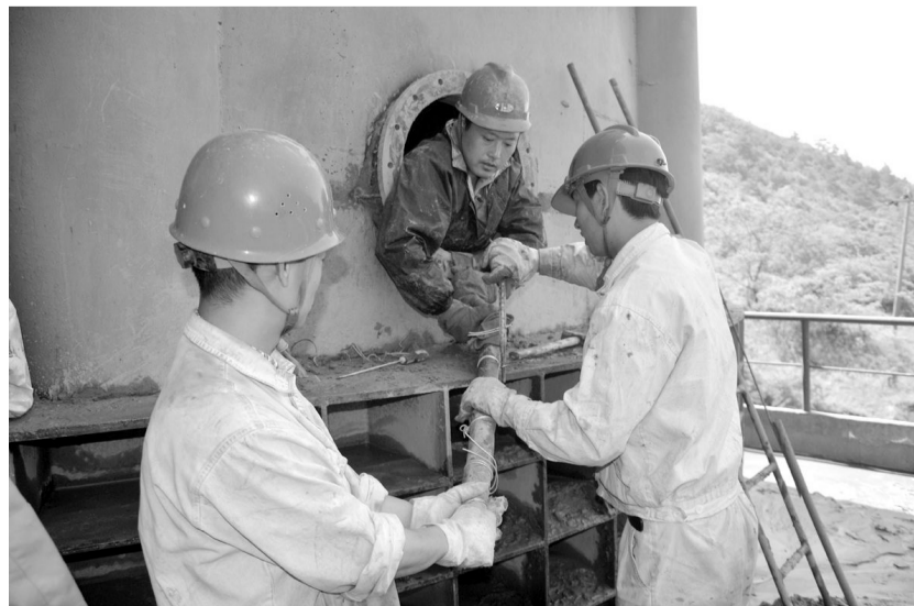
连日来,仙人桥矿业公司利用检修时机,组织人员加班加点对充填站两个立式砂仓和外仓进行清理,还对充填系统进行了整改和完善。图为5月15日,该公司员工清理砂仓的场景。 本报记者 江君 通讯员 周钧 摄
