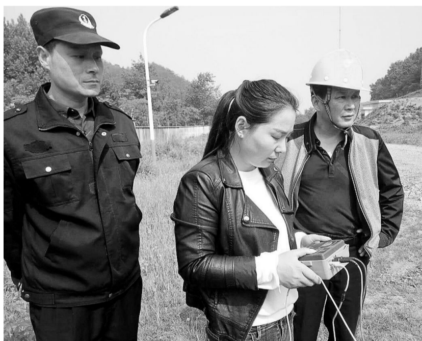
为预防雷雨季节气候灾害给矿山安全生产带来的影响,铜山铜矿分公司早行动、早部署、早落实,加大对要害部位以及生产涉高处(点)的电击与检测,保障雨季生产工作地安全畅通。图为4月28日,该公司聘请防雷检测专业公司在寒山炸药库检测防雷电击接地装置。吴 健 刘少级 摄
