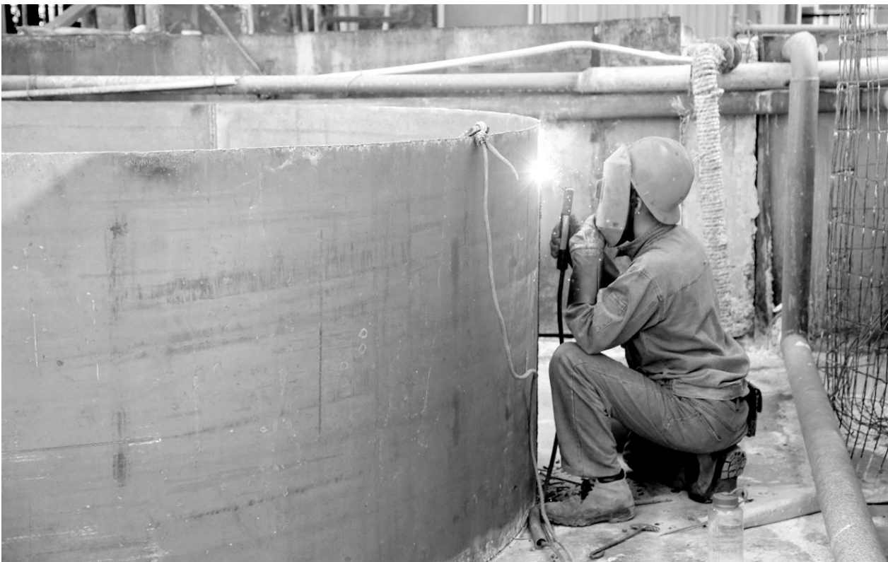
铜冠投资神虹公司职工日前正在制作环保设施储碱罐。铜冠投资神虹公司根据要求,近期全面开展了排查梳理环境隐患,并邀请专家会诊,认真制定整改方案、整改措施。同时,明确时间节点,落实责任人,严格按照整改方案有序推进,将问题全面整改到位,打赢环境治理攻坚战,促进企业绿色环保发展。
