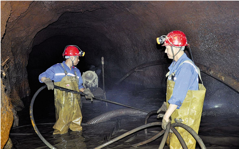
为保证井下安全生产，确保排水系统工作正常，5月1日，铜山铜矿分公司组织人员对该公司井下负658米水仓进行清理，使排水系统畅通，进一步保证雨季防洪工作顺利进行。
