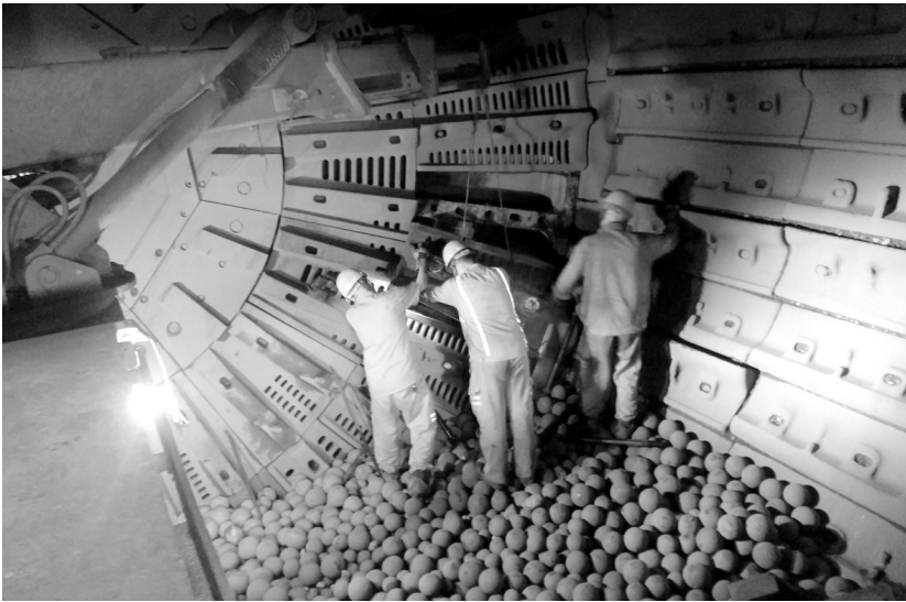
冬瓜山铜矿加大设备的维修保养力度，提高设备高效运转率，确保全年32000吨铜量任务顺利完成。日前，该矿选矿车间对半自磨衬板等设备进行检修（如图），并集思广益动脑筋、想办法，提高更换工艺，缩短检修时间，为后续生产创造有利条件。
