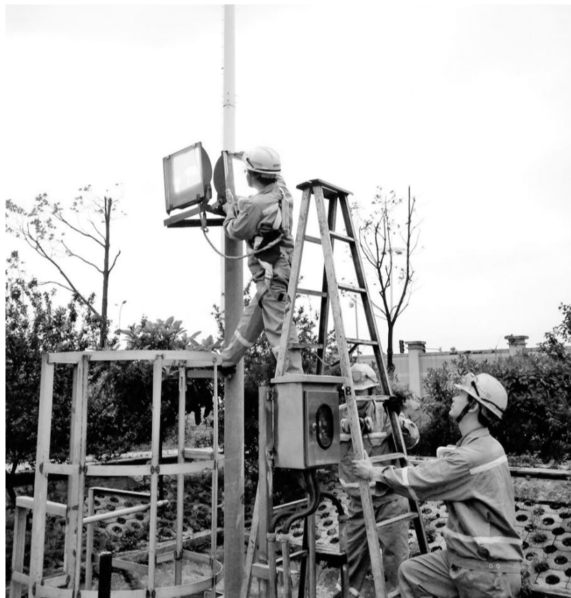
金隆铜业分公司保全车间维修人员日前正在维修灯具。随着雨季季节的临近,为保障全厂照明工作正常,金隆铜业分公司保全车间近期组织维修人员对全厂室外照明设备中的灯具、接线盒、防水弯、电缆绝缘及电缆接头防水处理等部位进行全面检查、维护。 王红平 杨捷摄
