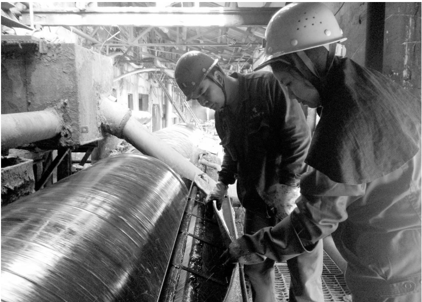
日前，天马山矿业公司选金车间顺利完成磁选机维修更换。该车间维修人员克服操作空间狭小、工作难度大、安全要求高等困难，通力协作，顺利完成对磁选机体割除、制作、校正、安装等工序，磁选机已恢复正常运转。夏富青 张跃进 摄
