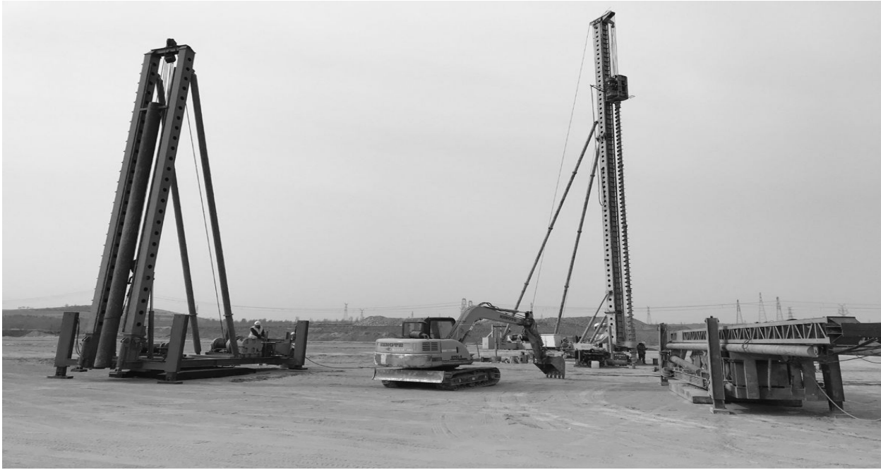
3月30日9时27分，内蒙赤峰金剑铜冶炼工艺升级改造搬迁施工现场，随着工程指挥员的一声令下，在鞭炮礼花和现场职工的欢呼声，桩基机械开始轰鸣，机械钻头缓缓地钻开地面向下工作，现场桩基试桩作业正式开始，这标志着铜陵有色铜冠建安公司参与金剑铜冶炼工艺升级改造搬迁大规模建设正式拉开帷幕。图为赤峰工程建设现场。
