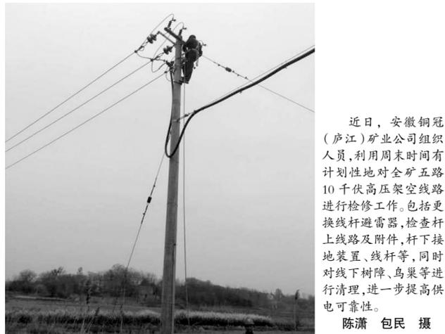
近日,安徽铜冠(庐江)矿业公司组织人员,利用周末时间有计划性地对全矿五路10千伏高压架空线路进行检修工作。包括更换杆塔避雷器,检查杆上线路及附件,杆下接地装置、线杆等,同时对线下树障、鸟巢等进行清理,进一步提高供电可靠性。
