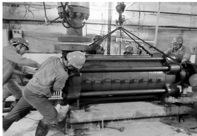
近日,安徽铜冠(庐江)矿业公司动力运转中心安排人员对排水设备进行维保。随着汛期的临近,该中心对井下主排水泵房的水泵进行全面检查与润滑保养,强化防汛防汛各项工作,做到防患于未然。 夏富青 高明照 摄
