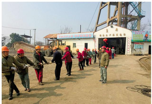
日前,天马山矿业公司机运二区对主井柔性罐道安全绳进行更换。该工区一直将查隐患、促整改、保安全放在首位,严格按照规范操作,各工作协调配合,按计划高速、有效、安全地完成这次更换工作。
