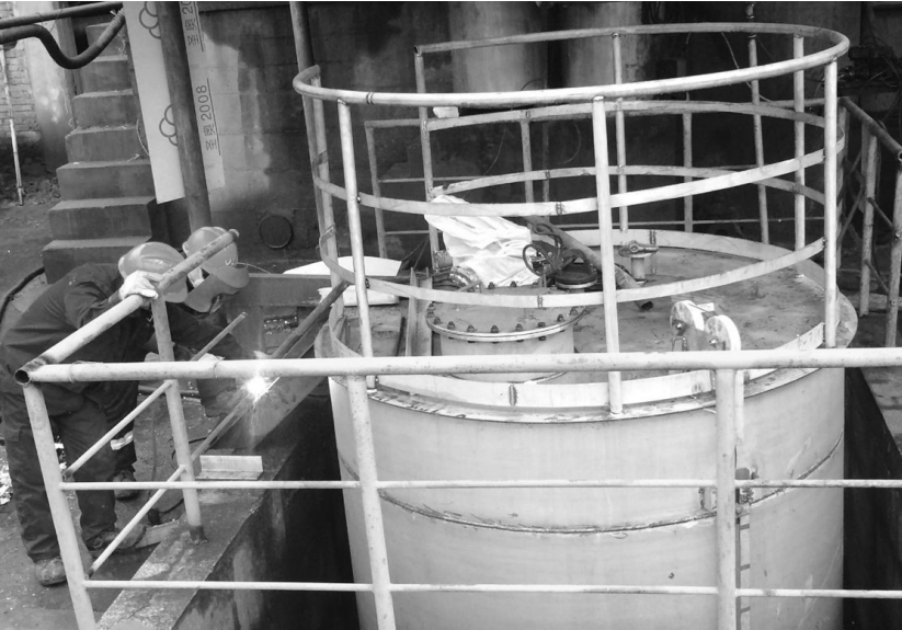
日前,天马山矿业公司造铜车间组织人员对硝酸罐进行更换。为做好此次储量为6吨的硝酸罐更换安装任务,该车间运用精细化管理手段,提前对施工地段的设备状态、施工环境等进行了翔实调查和准确测量,对施工作业程序和标准、现场的管理、施工安全保障措施等进行了细化安排,确保安装工程的安全和质量。 夏富青 周祖湘 摄
