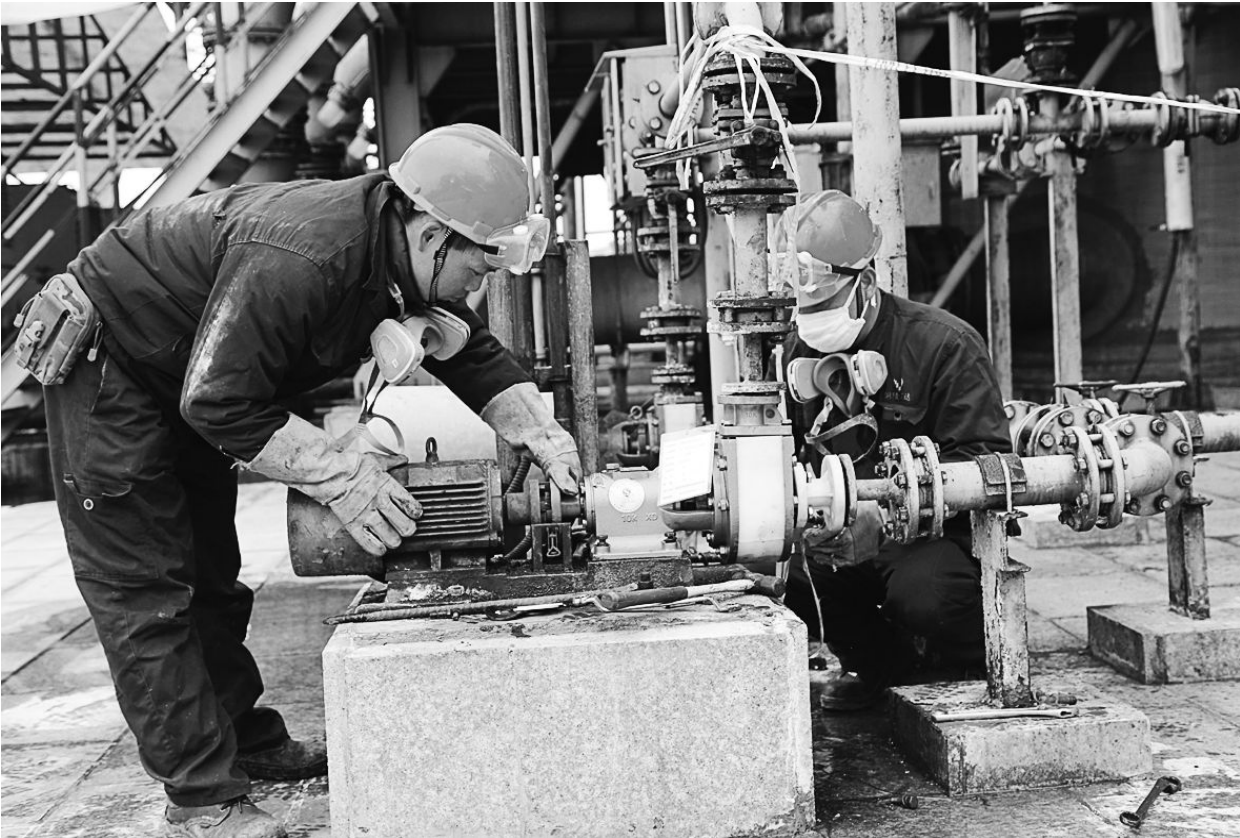
金冠铜业分公司厂区内协力服务人员正在维修作业。今年以来,金冠铜业分公司在精心组织“双闪”厂区生产中,积极抓好设备的维护保养,充分发挥协力单位的技术服务优势,及时对有隐患苗头的设备进行维保,保障了生产设备的稳定运行。 王红平 摄
