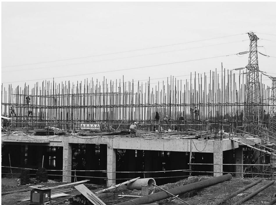
铜冠(庐江)矿业公司充填站日前正在基建施工。今年以来,随着斜坡道工程、尾矿库施工进入尾声,井下6个采场逐步展开,铜冠(庐江)矿业公司生产磨合正在提速。针对矿山采用的是大直径深孔阶段空场嗣后充填采矿法,为保证全面生产的稳步推进,矿业公司积极加快了地表充填站的建设,以确保采矿留下的采空区能及时得以充填。王红平 潘小祥 摄
