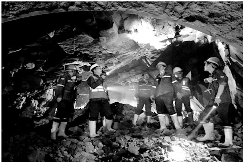
厄瓜多尔当地时间2月28日上午10点28分,随着米拉多铜矿铜达依米尾矿库初期坝导流洞最后一声爆破声响,由铜陵有色铜冠矿建公司承建全长650.7米、断面4乘5米初期坝导流洞工程全线贯通,并从施工准备期转入施工建设期,为米拉多项目明年试车投产提供了保障。
