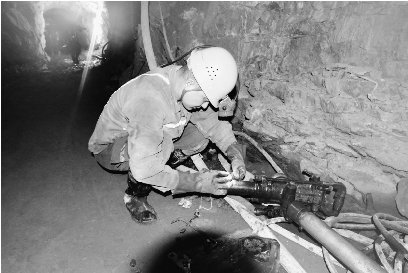
2月2日,在凤凰山矿业公司井下掘进采场,丁光荣对打眼机突发故障进行抢修,确保正常作业。该公司为鼓励员工一专多能,每年定期开展技能比武、岗位能手评选等活动,激发员工学技热情,提高生产战斗力。
