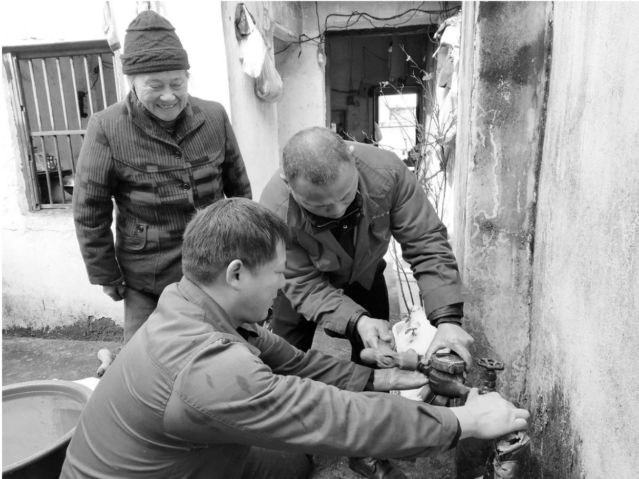
2 月 1 日，铜山铜矿分公司组织供水抢修人员正在为矿区居民更换新的水表，维修冻坏的水管。暴雪之后，针对气温连续下降这一现况，该公司启动冰冻灾害天气供水应急预案，加大供水设施巡检力度，确保铜山居民在严寒天气正常用水。
