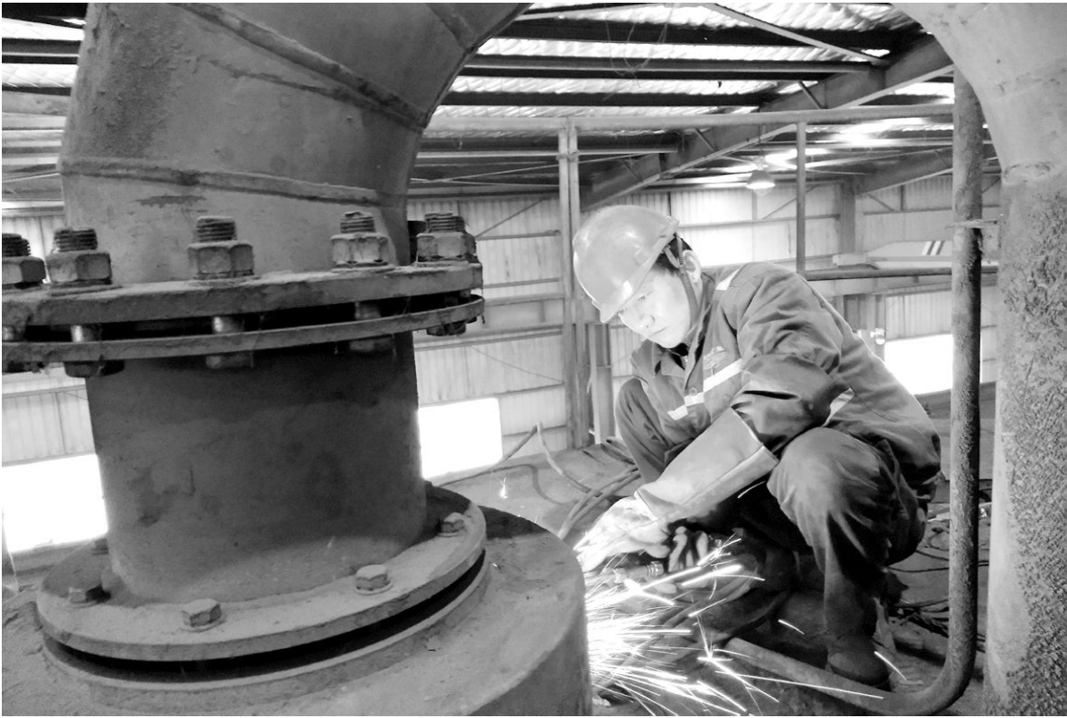
1月17日，铜山铜矿分公司选矿车间维修工正在对旋流器故障进行排除。今年，该公司以提高设备有效作业率为抓手，不断强化生产过程跟踪协调管理，坚持设备维护保养与预防性检修相结合，减少各种生产“小耽误”，为元月份稳产高产创造条件。
