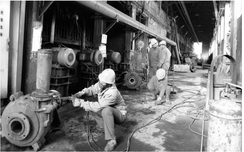
近日，天马山矿业公司选全车间磨浮工段维修人员正在维修选全渣浆泵。临近春节，该车间人员不断强化设备的保养和维修，确保车间生产安全有序进行。
