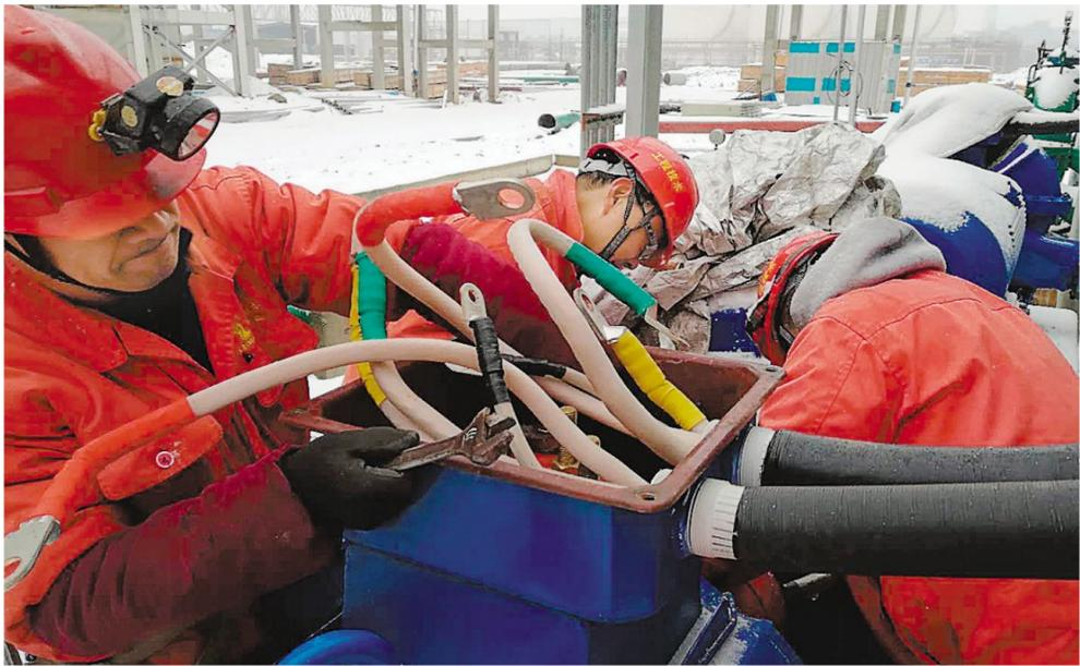
1月25日,工程技术分公司员工不畏风雪,依旧奋战在维修一线。图为该公司员工奥炉项目熔炼阳极炉循环水250千瓦水泵电机拆除施工现场。吴义龙 摄
