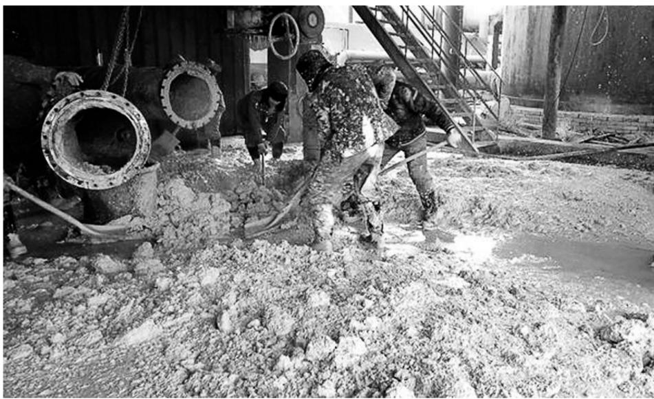
近日,金剑铜业分公司硫酸车间一、二期尾气处理一级塔塔壁粘结的渣泥脱落造成系统堵塞,为保证生产进度,该车间综合工段及时对堵塞渣泥进行清理,在预定时间前完成清理任务,为恢复正常生产创造了有利条件。 萨百灵 王 健 摄
