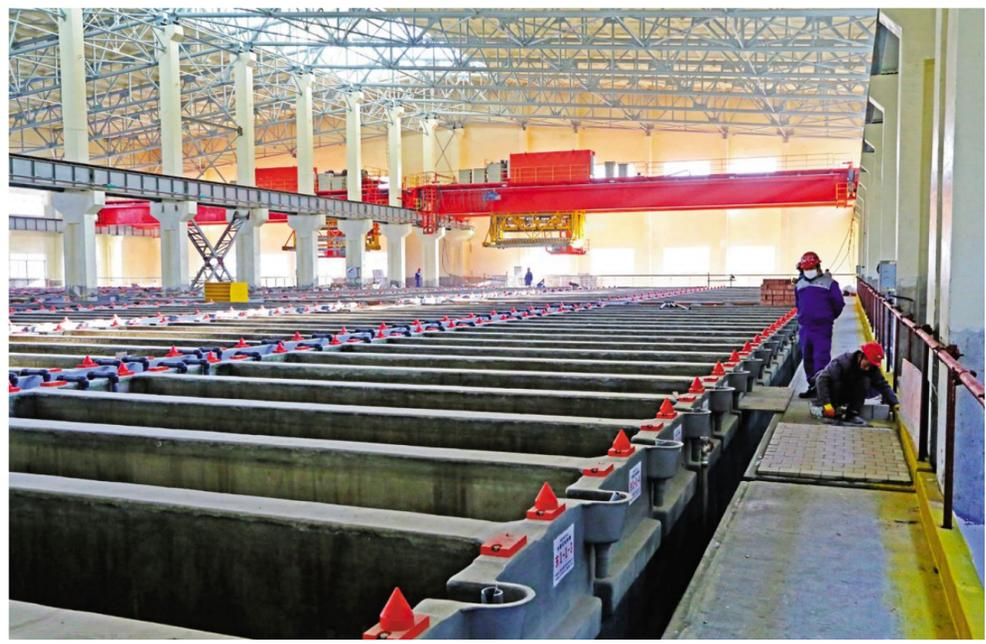
奥炉改造工程电解车间内日前正在扫尾施工。临近年底,奥炉改造工程中电解车间施工进入了扫尾阶段,电解及电解净液、电槽槽、行车等设备已安装结束,电解区域槽下地面铺设高分子材料业已全部顺利完工。目前正在安装机组,预计月底结束。王红平 齐宏明 摄
