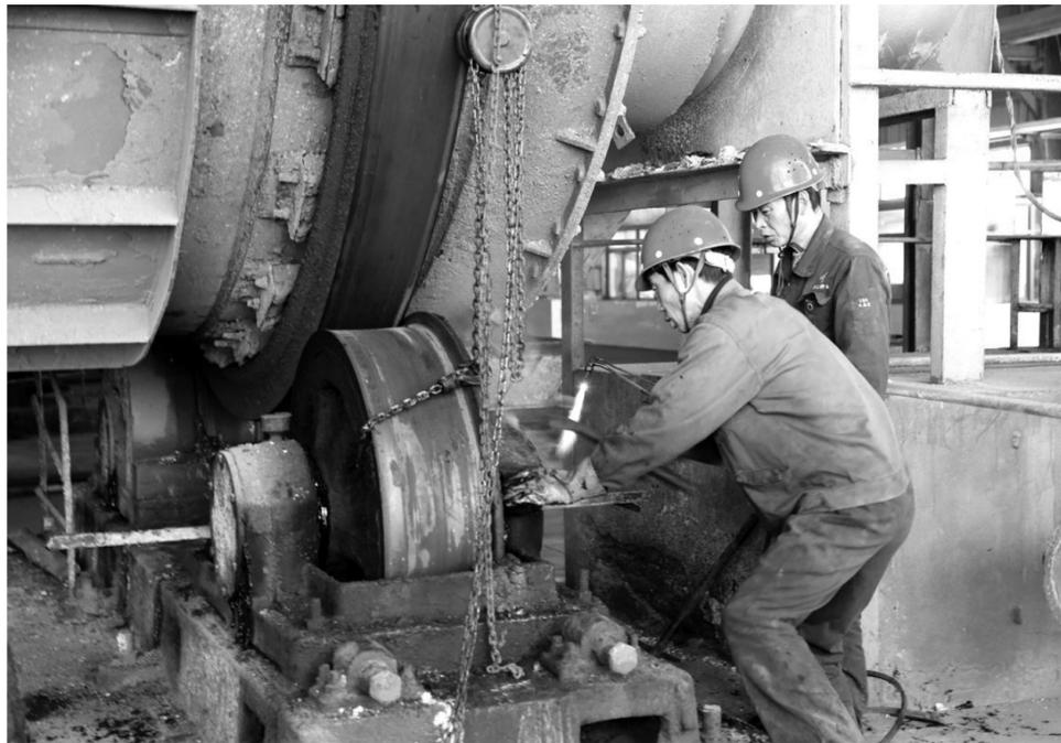
铜冠神虹化工公司职工日前正在检修转炉。铜冠神虹化工公司为实现安全环保生产,保障生产设备的稳定运行,每年均要对生产设备实行停产检修。日前,该公司组织开展了生产设备和环保设施的全面检修维护工作,并取得了检修预期效果。
