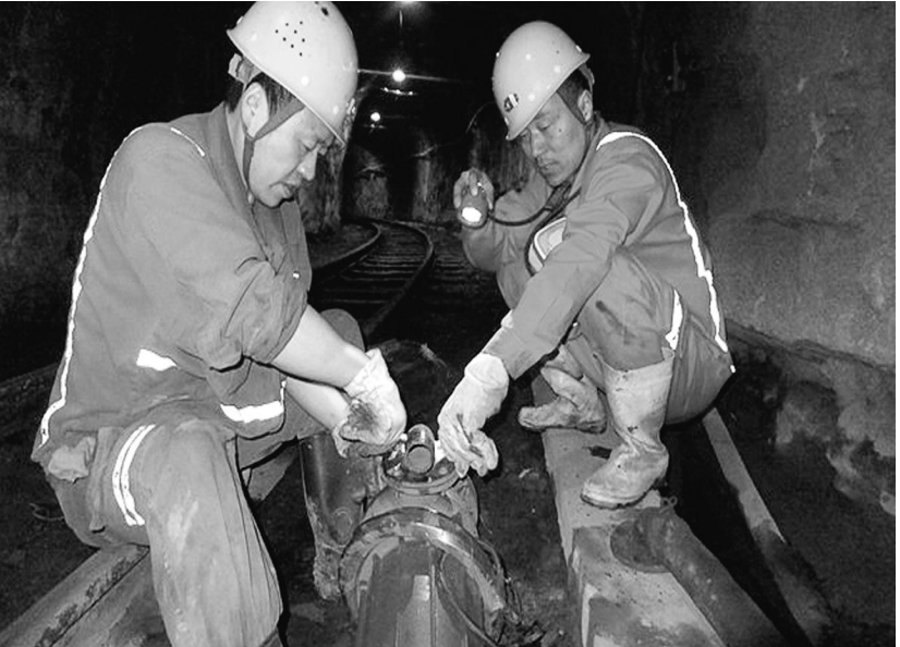
日前,冬瓜山铜矿运输区职工在井下负 875 米运输川脉检查维修更换水沟排水泵(如图)。这个区结合自身生产特点和井下实际情况,加大组织实施对该区重点防洪地域及设施巡查与整改完善,进一步夯实防范工作,确保正常生产。
