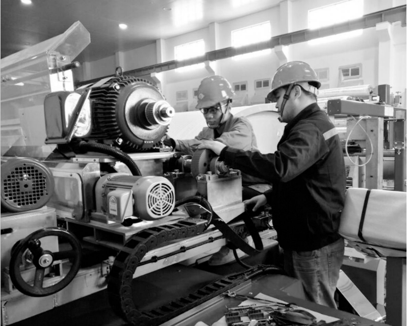
近日,安徽铜冠铜箔铜陵项目正在加班加点安装设备,确保按时间节点投入生产。该公司不断通过技术创新,培育和打造高端市场,力争做精做大做强做优。
