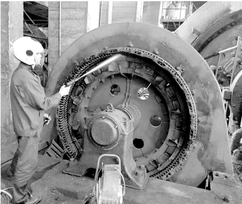
日前,天马山矿业公司透金车间组织人员对 5 号球磨机进行检修,并对高压电机的线圈进行在线绝缘清洗,清除金属粉尘,改善电机绝缘状况,延长电机使用寿命。图为专业人员在清洗电机线圈。
