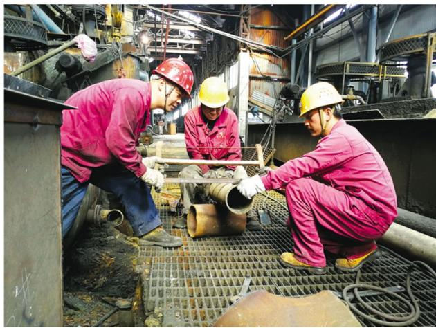
10月19日,天马山矿业公司选金车间内维修工人正在更换浮选机回路管。该公司年终检修工作如火如荼进行中,今年的年终检修工作项目多、任务重,该公司超前准备、周密部署、层层落实,严把检修安全关和质量关,力争圆满完成年终检修任务,为年底和明年的安全生产奠定坚实基础。
