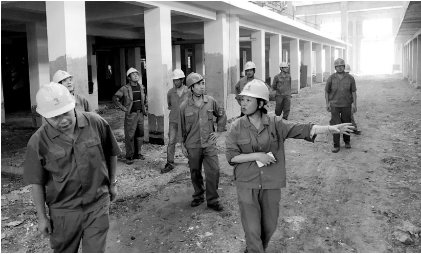
为保证“国庆”和“中秋”双节的安全生产,9月25日上午,铜冠建安奥炉行政项目部开展节前施工现场安全检查,保证“两节”期间的施工安全和各项环保措施有效实施。
