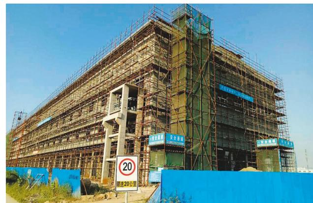
去年10月份进驻奥炉精矿项目以来，铜冠建安劳务公司精心组织，合理安排，精矿车间的内外脚手架以及物料提升机的施工均按照计划工期节点顺利推进。图为车间外脚手架完工后的情形。
