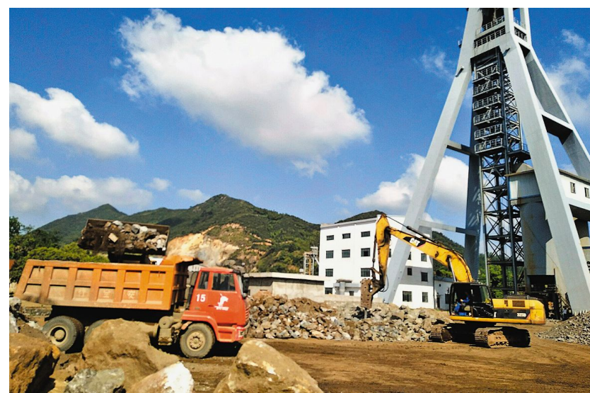
9月16日，铜山矿业公司原矿堆场工程正式动工新建。据了解，该公司根据生产经营实际情况，拟新建一储存能力在6000吨以上的原矿堆场，计划工期30天，分两期建设，先期建设堆场挡墙，二期同步建设钢结构大棚基础以及雨污分流系统，在达到封闭降尘要求的同时，也满足了矿山生产需求。张霞 摄
