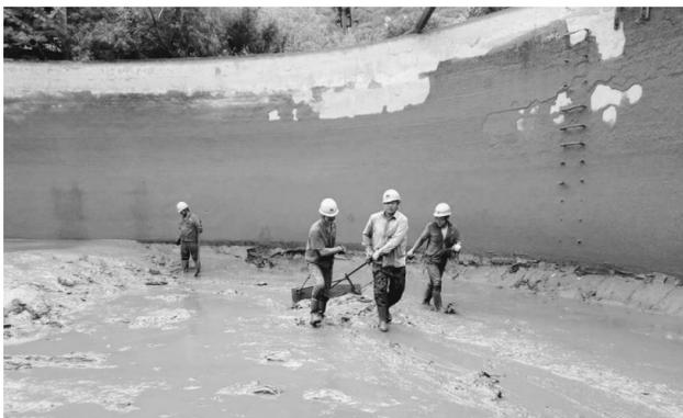
日前,凤凰山矿业公司选矿车间磨浮工段利用停车备矿期间组织人员对2000吨蓄水池底部的淤砂进行清理。清理人员下到池底用铁锹铲运,反铲拖运,高压水枪冲洗淤泥,保证其能通过底面顺利排出。他们不怕脏不喊累,奋勇争先。经过9个小时的奋战,2000吨蓄水池底部的淤泥都清理干净,为今后的生产创造了良好的条件。 钱叶华 管海东 摄
