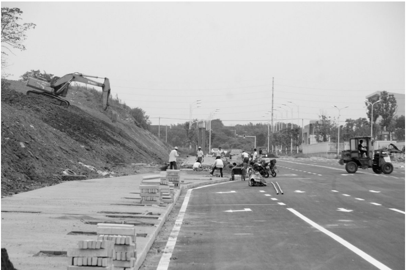
9月5日上午，笔者看到坐落于经济技术开发区联通华山大道至石城大道的东路一路(如图)建成，即将通车。据市建投公司有关人员介绍，东湖一路全长400多米，路幅宽25米、双向4车道。两边人行道各宽4.5米，目前正对两边人行道进行绿化和边坡平整。此路的建成通车将大大方便附近居民生活和子女上学的问题，同时对完善开发区的路网建设有很大意义。
