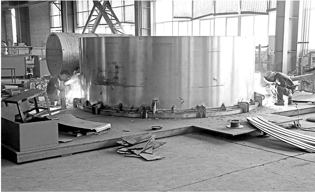
铜冠机械公司加工制造分厂职工日前正在制作不锈钢槽罐。铜冠机械公司加工制造分厂在集团公司重点工程铜陵铜箔项目中承担了105台套不锈钢槽罐的制作安装任务。由于时间紧，工作量大，为保证工程建设需要，加工制造分厂从3月份开始加工以来，投入了精干力量加班加点全力赶制，特别是当现场条件符合时，立即开始边制和安装同步进行，较好地保证了工程进度。
