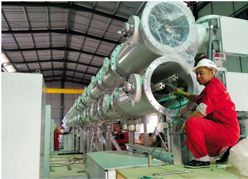
厄瓜多尔米拉多铜矿组织人员安装矿山主变系统。据悉，经过多方努力和刻苦攻关，该矿主变系统安装工作基本完成，高压配电装置正有条不紊进行安装中，确保按照既定时间完成目标任务。
