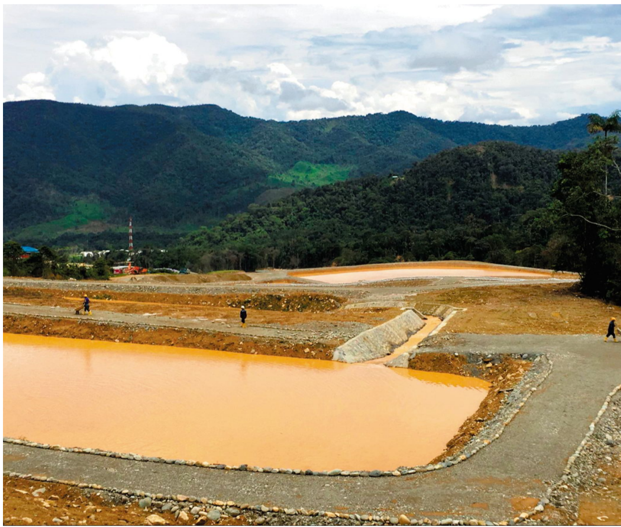
日前,铜冠建安公司承建的厄瓜多尔米拉多铜矿每年2000万吨采选项目选矿沉淀池工程(如图)一次性通过竣工验收。该公司克服了雨水天气多、施工区域块石和淤泥多、机械设备资源匮乏等困难,采取24小时两班制施工,夜班施工管理人员轮流带班等措施,较合同工期提前15天完成所有施工内容,赢得了业主的肯定与好评。
