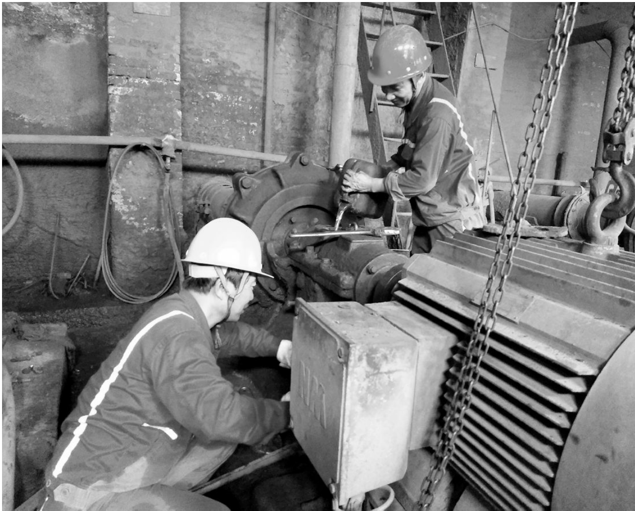
在冲刺下半年安全生产过程中，铜山矿业公司积极做好设备的维护与保养，不让“干活”的重要设备因为故障影响到正常生产。图为近日闷热的天气里，该公司维修人员汗流浹背地抢修选矿设备的情景。
