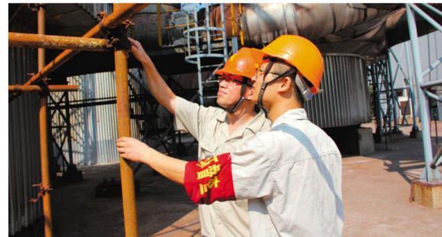
铜冠石化分公司硫酸车间“每日安全员”“青安岗”成员正在对一期换热器检修脚手架搭建情况进行安全确认。进入夏季以来,该车间硫酸车间加强安全监管,安全员和青安岗成员每天深入作业现场,排查安全隐患,确保设备安全持续运行。 朱长华 何 鹏 摄
