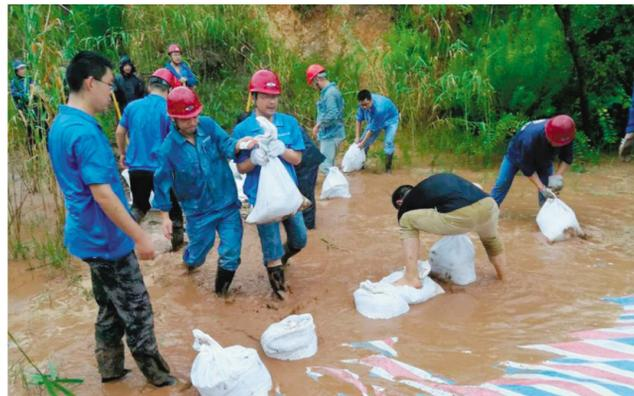
8月8日上午，雷电、大风、强降雨突然来袭，导致仙人桥矿业公司尾矿临时堆场出现险情，该矿业公司迅速组织机关及基层单位员工，在尾矿临时堆场周围用编织袋、防雨布冒雨突击筑起了拦阻坝（如图），有效防止了尾矿外泄。
