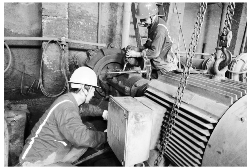
7月31日,铜山矿业公司选矿车间尾矿工段设备维修人员冒着近38摄氏度的高温,对二级泵出现的异常情况及时进行处理。为减少当前持续的高温天气给矿山安全生产带来的影响,该公司在做好人员防暑降温工作的同时,有计划、有针对性地做好各类机械设备的通风、降温工作,对重点设备实行专人管理、定时检查,及时消除各类事故隐患,确保高温期间矿山生产正常运行。 本报记者 江君 通讯员 张霞 摄
