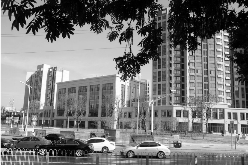
7 月 16 日，笔者在位于长江西路与铜官大道交叉口的天桥棚户区改造工程现场看到，经过一年半的紧张施工，如今这里已经成为环境优美，各类乔灌木错落有致的“天桥花园”。一栋 17 层综合楼、两栋 11 层小高层及一栋 5 层商业用房，总户数达 238 户的民生民生工程全部完工（如图），并有不少居民已经搬进新居。据悉，此工程已被评为市级安全质量标准化示范工程。
