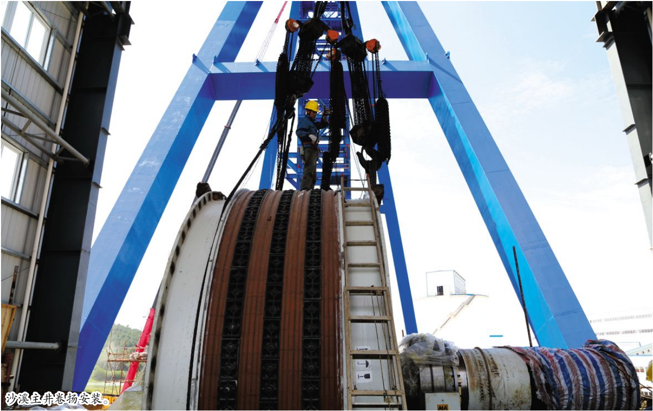
沙溪主井卷扬安装。
