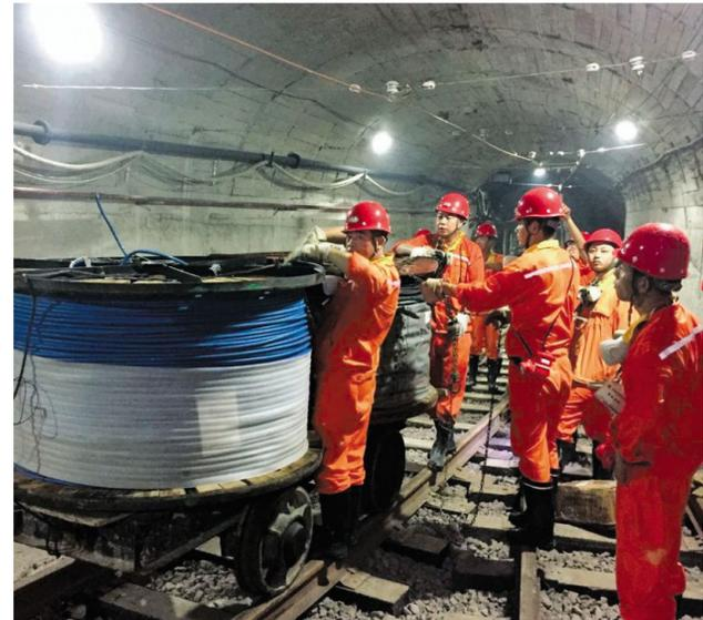
近日，安徽铜冠（庐江）矿业公司动力运转中心组织人员在负800米路段敷设电源电缆和通讯光纤，确保“信号、集中、闭塞”系统投入使用，合理调度电机车和提高运输效率，确保行车安全，实现大巷运输现代化。 夏富青 张琦 摄
