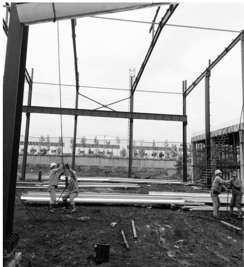
6月15日,在泥污的施工现场,建安钢构公司员工正在认真吊装钢结构制作件。单重100多斤的制作件每次在上下协同配合工作的七名员工配合下才能安全吊装至十米高以上的指定位置。该公司在承建的漂亮铜业公司厂房建设中,加班加点,力赶工期,目前各项工作顺利开展。本报记者 江君 通讯员 马能飞 摄
