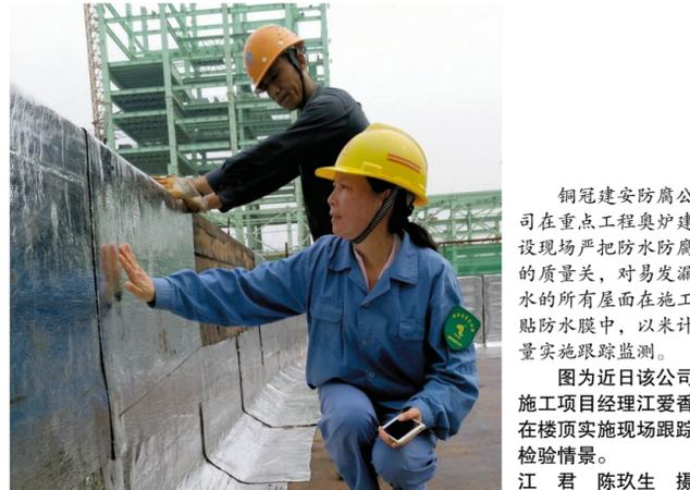
铜冠建安防腐公司在重点工程奥炉建设现场严把防水防腐的质量关,对易发漏水的所有屋面在施工贴防水膜中,以米计量实施跟踪监测。
