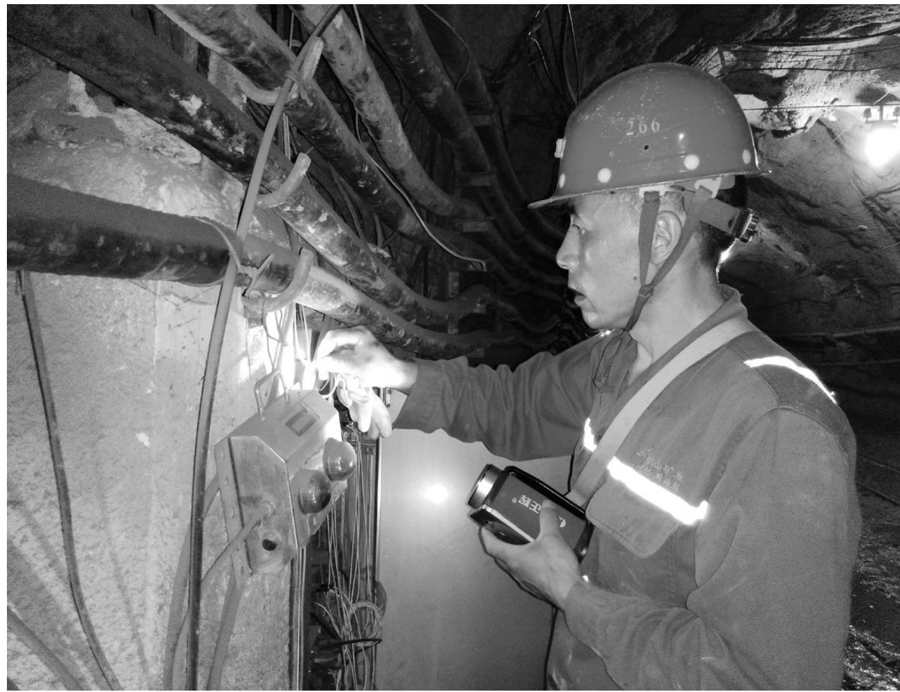
铜山矿业公司以打造数字化矿山建设为目标,不断加大科技投入,积极引进、吸收和转化新技术、新成果,在提供传统语音业务的基础上还可提供图像、视频等宽带数据业务应用,为提高生产效率、降低安全风险提供了技术保障。图为该公司信息技术中心工作人员在井下负658中段,对监测监控、人员定位和通讯联络等地下矿山安全避险六大系统中的数据网络设施进行检查维修。方发达 摄
