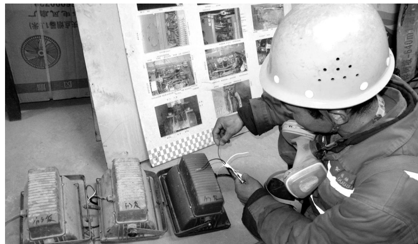
冬瓜山铜矿大团山工区广大职工在降本增效活动中,积极动脑想办法。日前,该区维修班人员把以前更换下来的报废节能灯,将拆卸下零配件安装在3盏有故障的节能灯上,修复后分别安装在负670米、负730米中段大巷道。此举既培养了员工们小改小革创新意识,又节约了材料费用。 徐志勇 摄
