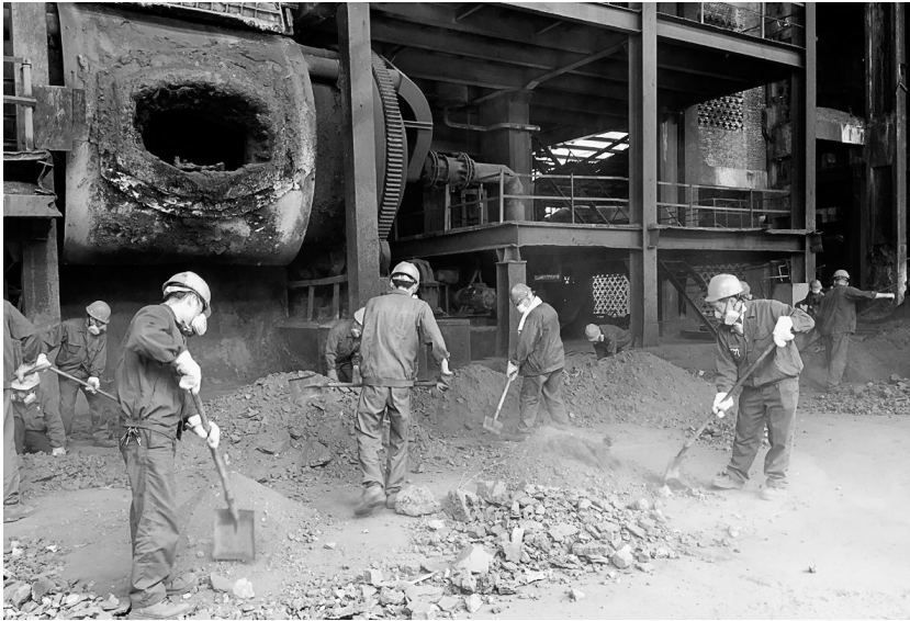
自4月20日停产以来,金昌冶炼厂各项清理工作按计划有序进行。图为熔炼车间内,清理人员正集中对含铜物料按块状和粉末状进行分堆。
