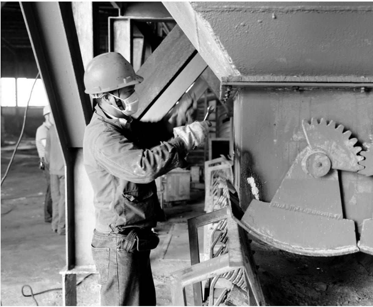
铜冠投资神虹化工公司职工正在技改施工。铜冠投资神虹化工公司利用近期停产检修契机,对原料自动运输系统进行了技术改造。通过技术改造可使原料上运输线时减少灰尘,改善作业环境,同时降低职工操作劳动强度,技改取得了预期效果。
