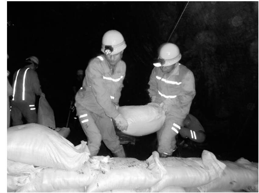
凤凰山矿业公司工程车间克服采场充填管道长、架设难度大等困难,对采场进行尾胶打坝分段充填,虽然加大了充填难度和劳动强度,但为日后高效的采矿奠定了基础。图为该车间充填班人员在采场进行打坝作业时情景。
