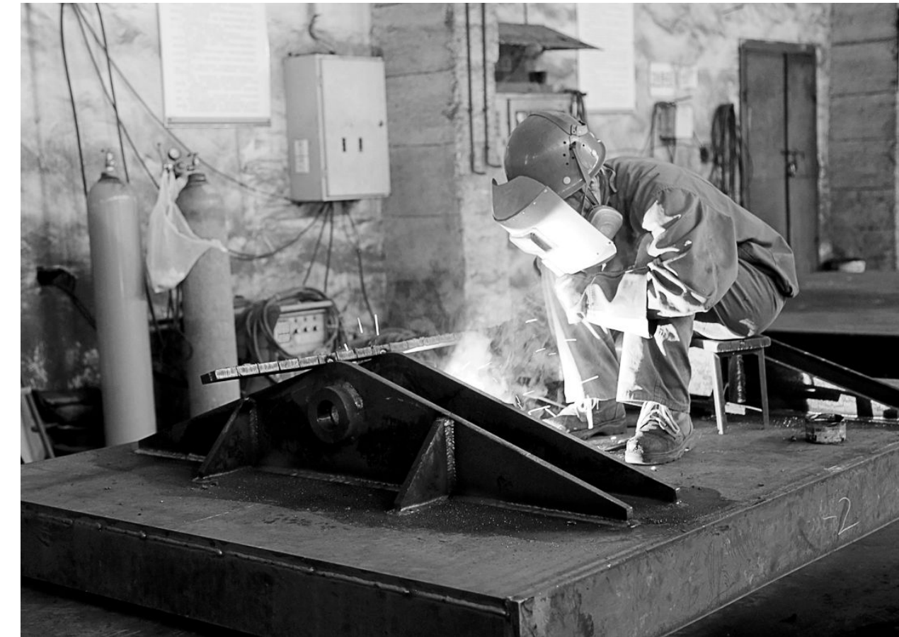
铜冠机械公司矿冶制造分厂职工目前正在焊接阳极炉炉盖。随着集团公司奥炉改造工程全面进入安装阶段,由铜冠机械公司矿冶制造分厂承担的其中7台炉体制作也进入了紧张的交货期。该分厂通过全力赶制,目前,奥炉和电炉已运到现场安装,3台转炉完成了大部分制作工作量,2台阳极炉也进入了组装焊接阶段。制作进度满足了工程建设要求。 王红平 王征社 摄
