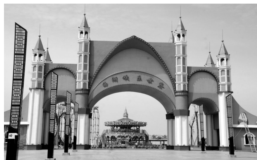
5月7日,笔者在“西湖欢乐世界”建设工地看到,投资超过上亿元的我市最大的文化创新项目扫尾工程正在加紧建设。据项目部负责人介绍,该工程将于5月20日左右正式投入运营。届时,这里将成为铜陵市乃至沿江地区最大的儿童娱乐活动中心(如图)。 殷修武 摄
