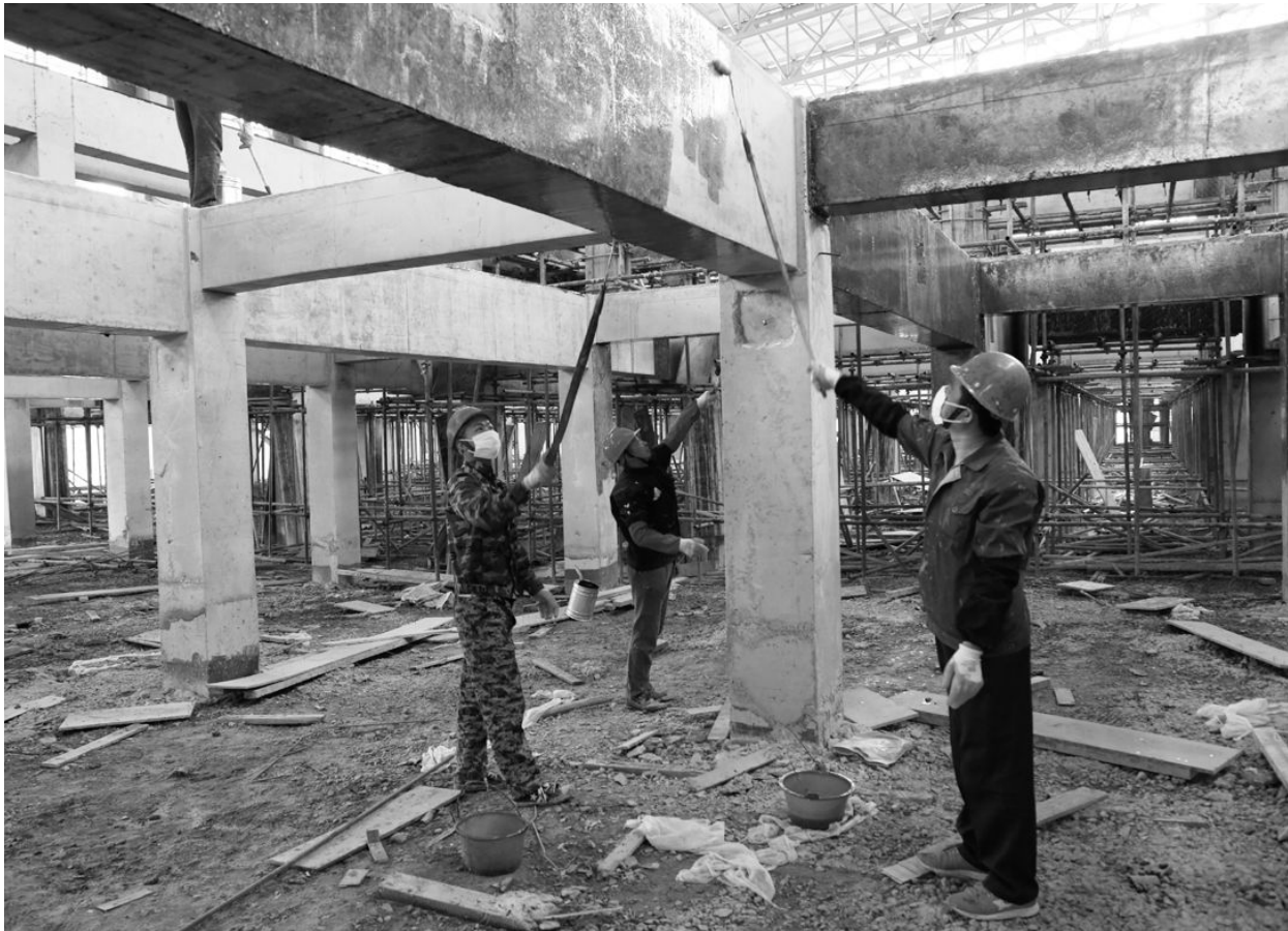
4月21日，有色建安防水防腐公司职工正在奥炉技改工程电解区域开展电解槽支架防腐施工。在奥炉技改工程中，有色建安防水防腐公司承担了电解车间、精矿库、污水池等多个项目的防腐施工，防腐施工面积工程量大，工期紧。该公司施工人员起早摸黑，合理安排施工，较好地保证了施工进度。
