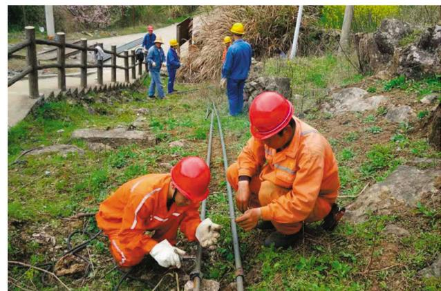
由于相思谷尾矿库在用的三相四线低压架空线已使用多年,考虑到随着相思谷景区的旅游不断开发,游客人数的逐年增加,存在极大的安全隐患。凤凰山矿业公司日前对其进行整改。担任此项整改任务的机运车间供电班、维修班的党员发挥共产党员先锋模范作用,克服坝体坡度大、地表障碍物多施工条件复杂等困难,人工登杆拆除架空铝绞线300米,铺设安装保护套管200米,低压电缆100多米,顺利完成了整改任务,有力的保障了这个公司相思谷尾矿库的照明和监控的用电需求。图为整改现场。
