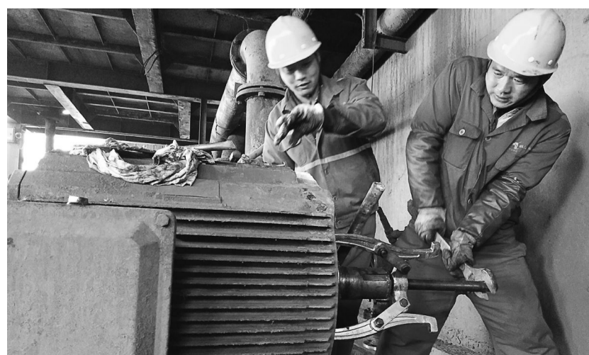
今年，铜山矿业公司围绕成本、质量、效率和效益等关键指标，深挖设备管理新思路，以精、准、细、严的原则，严把设备巡查、维护保养、检修等各个环节，确保各类设备零缺陷、安全高效运转。图为日前该公司选矿车间维修工正在更换磁尾泵轴承。
