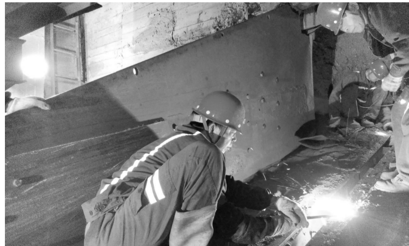
4月7日，铜山矿业公司运转区维修人员在更换负658米破碎机漏斗衬板。该公司积极开展挖潜增效活动，推动了公司生产平稳发展。余飞 吴健 摄
