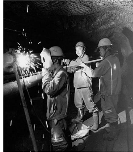
针对井下充填跨中段多、管道线路长、检修施工点散等难题,冬瓜山铜矿充填区在认真抓好日常维护点检工作的同时,根据当班维修工作量的大小,适时将电工、焊工、支护工“混合”到生产班组,由生产班组和维修班组强强联手,快速排除各类隐患故障,保障充填安全有序运转。图为维修焊工在生产班组人员的配合下焊补充填管道。 汪为琳 摄
