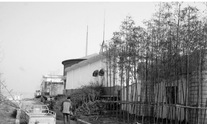
2月26日上午，笔者在铜陵有色动力厂供水车间看到，循着滨江岸线北延伸段整治工程的加快实施，供水车间将被掩映在翠竹松柏绿树丛中，成为铜陵有色环境最美的车间之一。图为市绿化队人员正在该车间旁栽翠竹。
