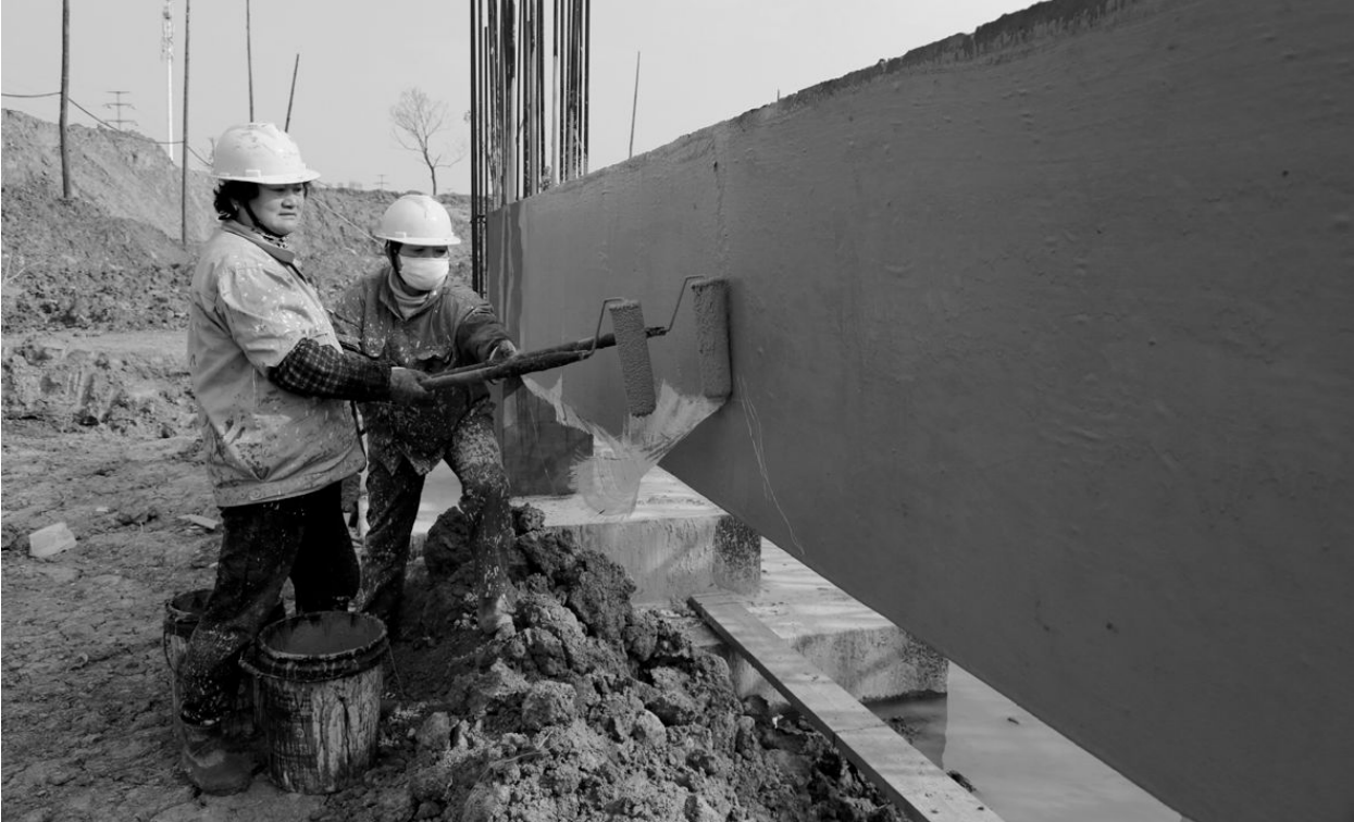
2月21日,有色建安防水防腐公司职工正在铜陵铜箔项目中进行地梁防水防腐作业。在去年底开工建设的铜陵铜箔项目中,有色建安防水防腐公司承接了其中防水防腐专业施工业务。自今年元月进场防水防腐施工以来,先后开展了项目基础台、地梁、设备基础等防水防腐施工,目前,施工面积达2500平方米,较好地保障了项目主体施工建设进度的需要。
