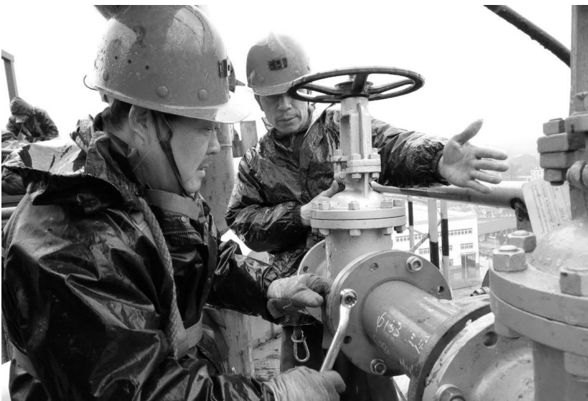
2月22日,铜山矿业公司工程区维修人员在抢修尾胶充填管道。为加大采运矿生产的稳步发展,近年来,该公司在引进新技术、新工艺、新设备的同时,十分注重产能与环境保护的治理整改,充分利用废弃资源加大井下采场采空区的充填,使公司的安全环保工作跃上新台阶。
